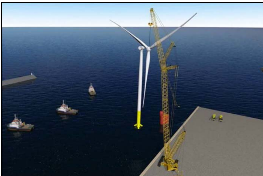
Figura 7.1: montaggio di un aerogeneratore in banchina
